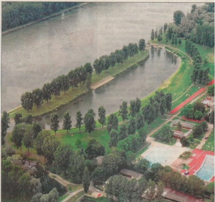
DAS KARLSRUHER RHEINSTRANDBAD Rappenwört muss im Zuge des anstehenden Polderbaus Vorgesehen ist eine lange Stahlsplundwand. Alternativ angeregt wurde eine Erdschüttung.
